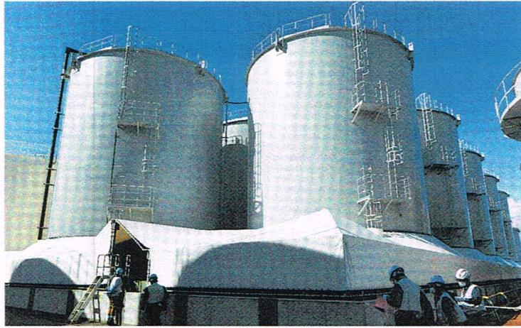
処理水の貯蔵タンク。足回りには雨水対策のカバーが施されている
